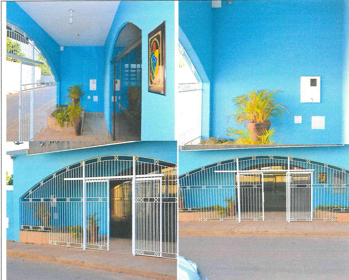
Descrição: reparos nas infiltrações e pintura em tinta látex acrílica / duas demãos ou mais onde foi necessário para cobertura total, nas cores indicadas e aprovadas pela fiscalização após amostra (paredes e grade do rol de entrada / Plenário).
