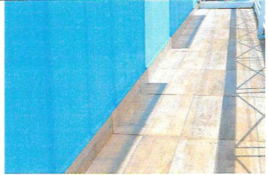
Descrição: reparos nas infiltrações e pintura em tinta látex acrílica / duas demãos ou mais onde foi necessário para cobertura total, nas cores indicadas e aprovadas pela fiscalização após amostra. Pintura dos barrados, verniz nas janelas, grades, muro, portão (área externa).
